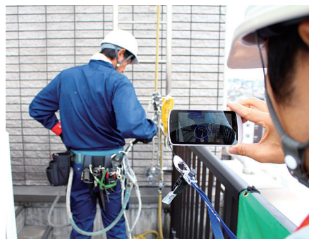
KYミーティングでの安全事項読み上げ、高所作業時の安全装置確認は指差しを伴って入念に行われ、その風景が「PhotoRAC」を使って現場担当者により事務所に報告される
